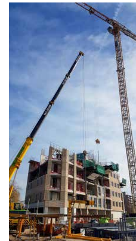
Bouwwerkzaamheden Bij de Zijl.
